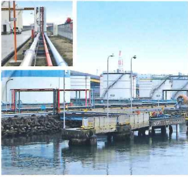
DATA ▶ 東西オイルターミナル株式会社殿向 【八戸油槽所パイプライン各種】 1990年4月施工
