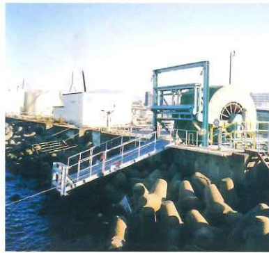
DATA ▶ 新日本石油青森油槽所殿向 【オイルフェンス巻ドラム及びラダー設備】 1994年6月施工
