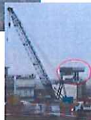
▲後日送っていただきました工事の様子です。集合写真後ろの製作物が赤丸部分の上部の台です。脚の部分は現場での組立とのこと。すごい！
